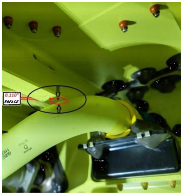
Figure 1 – Emplacement du dégagement insuffisant entre la conduite d'alimentation carburant et la lisse dans le réservoir collecteur
